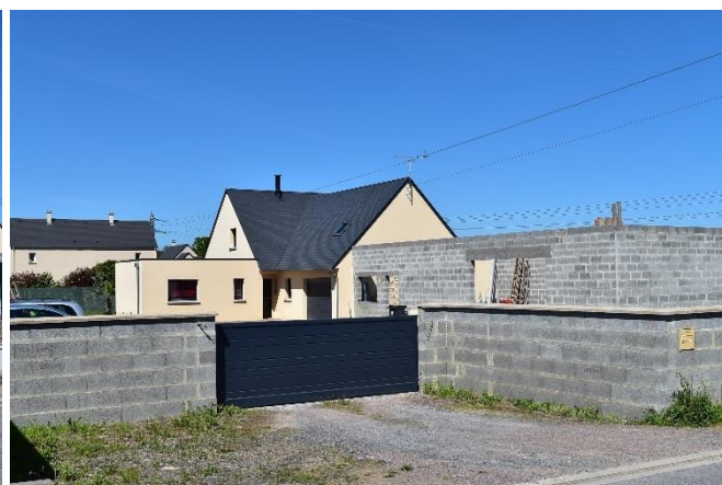
La ZA, au Sud de la RD214 accueille des bâtiments de taille diversifiés
